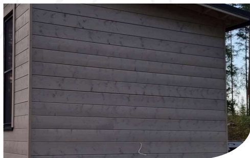
Hirsipaneeli on tehty jäljittelemään hirren ulkonäköä.
