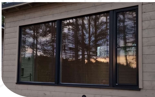
Talvikäyttöisessä tilassa käytetään 3 lasiasikkunootta, kuten asuinrakennuksissakin.
