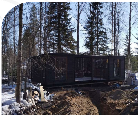
Piharakennus on räätälöitävissä tarpeiden mukaan. Kuvassa rakennuksen paikalleen asennus käynnissä.
